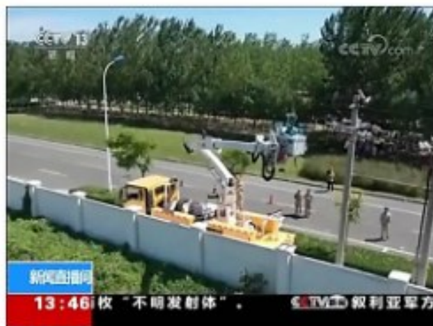
“创享Ⅲ号”带电作业机器人项目
