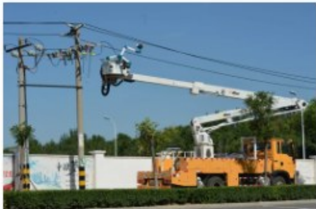
“创享Ⅲ号”带电作业机器人项目
